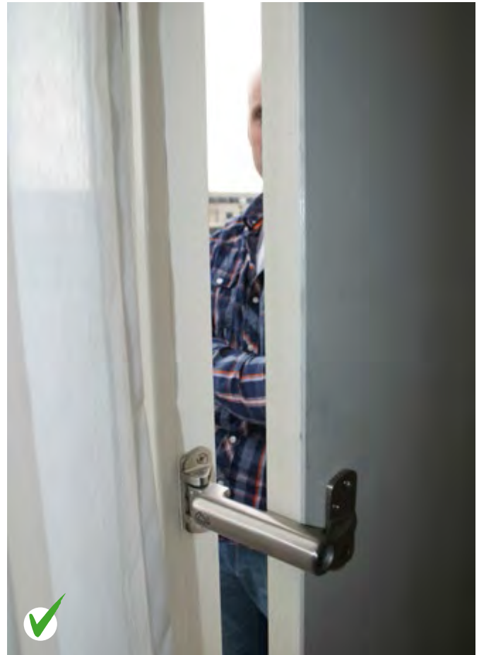
Een gecertificeerde kierstandhouder bij het openen van de deur, gebruik deze niet als extra slot.
