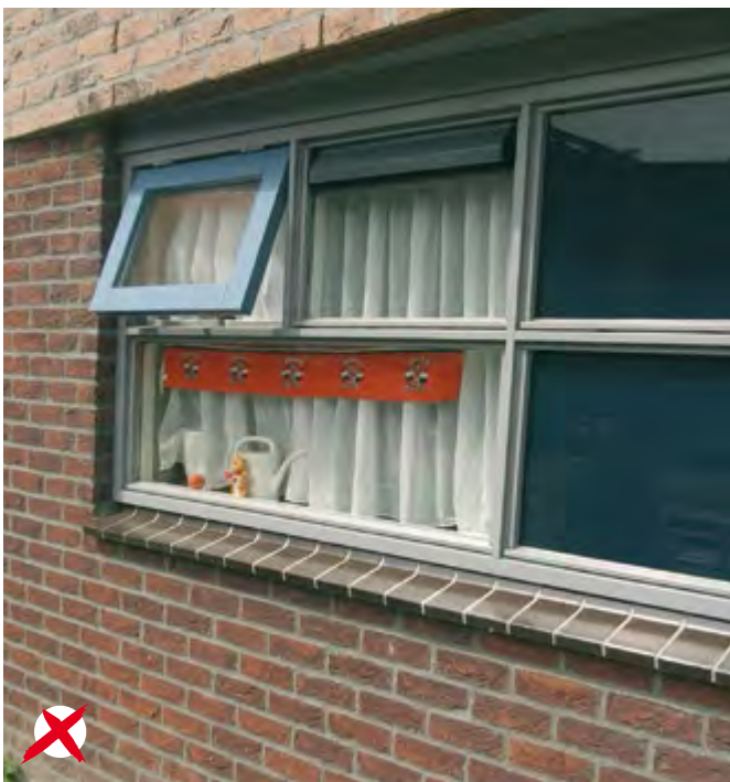
Een raam is inbraakwerend en moet afgesloten zijn als bewoners afwezig zijn.
