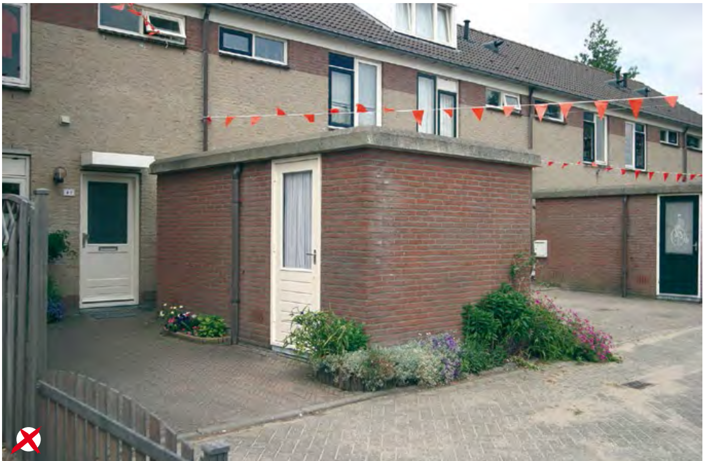
Fout: tussenruimte tussen berging en gevel (nis) zorgt ervoor dat mensen zich kunnen verstoppen.
