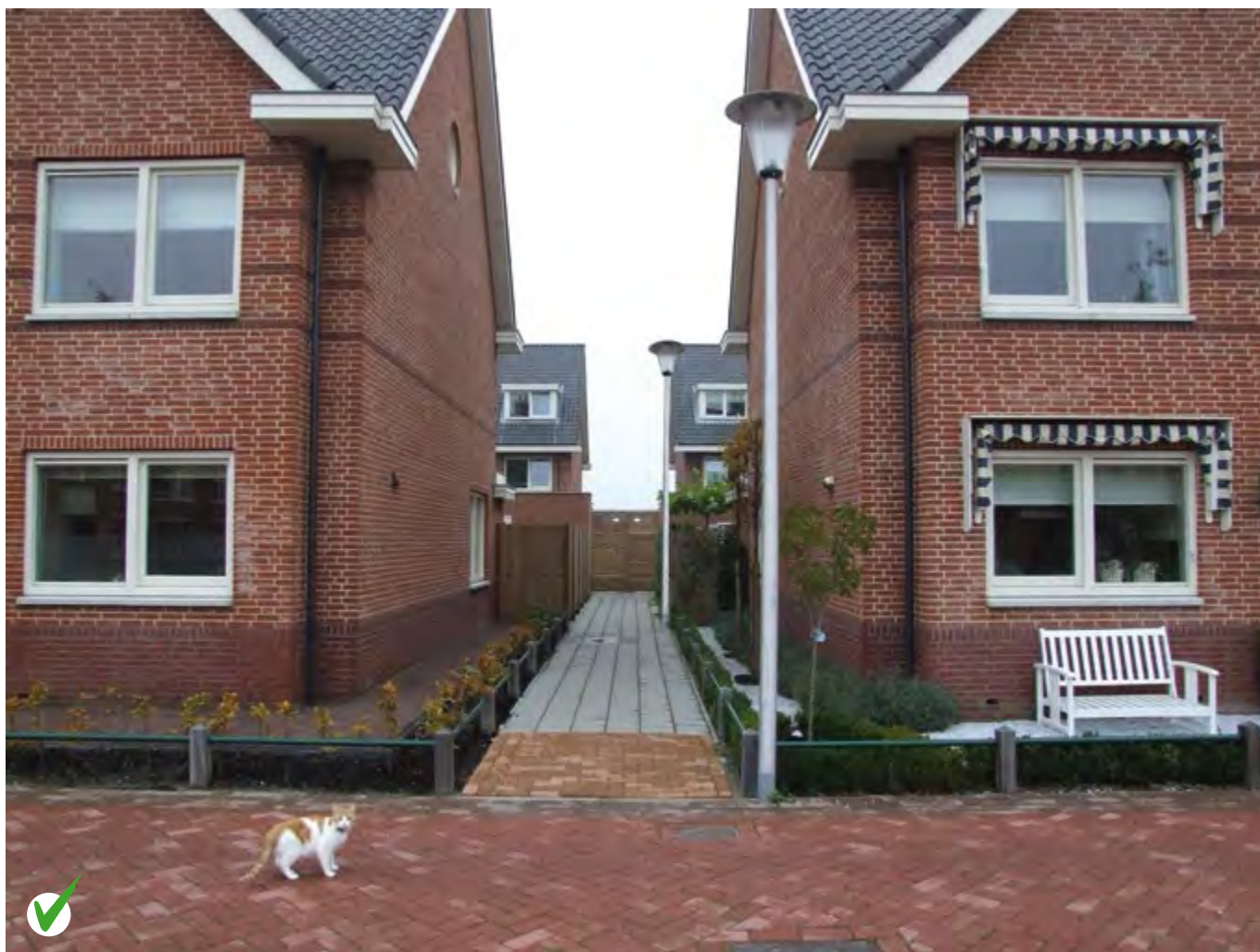
Goed: openbare verlichting aan het begin van het achterpad heeft meerwaarde.
