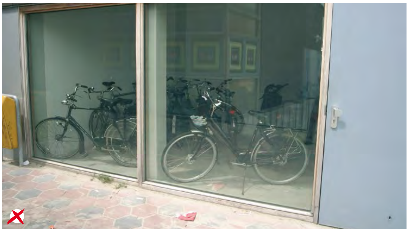
Dit is geen gewenste situatie. Let op: het glas direct naast deze toegangsdeur dient minimaal P2A te zijn en bij voorkeur is er geen zicht op de fietsen/scooters van buitenaf.
