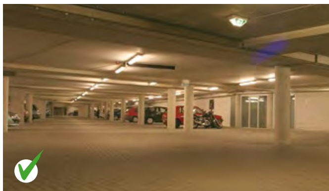
Een garage, gekoppeld aan een woongebouw, moet overzichtelijk en goed verlicht zijn.
