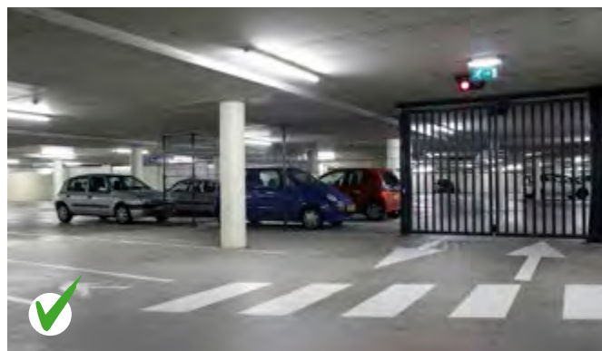
Het gedeelte voor openbaar parkeren is afgeschermd van het gedeelte dat voor bewoners bestemd is.
