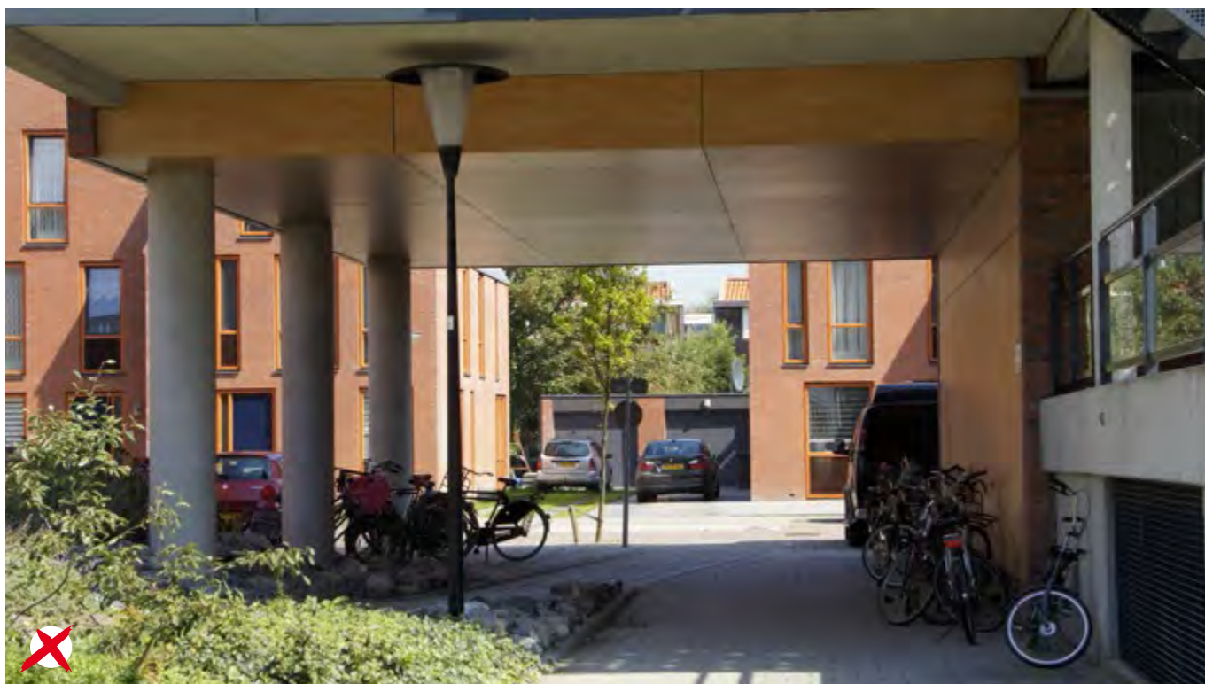
Fout: de verlichting zal niet de hele onderdoorgang kunnen verlichten, het plaatsen van fietsen is niet geregeld.
