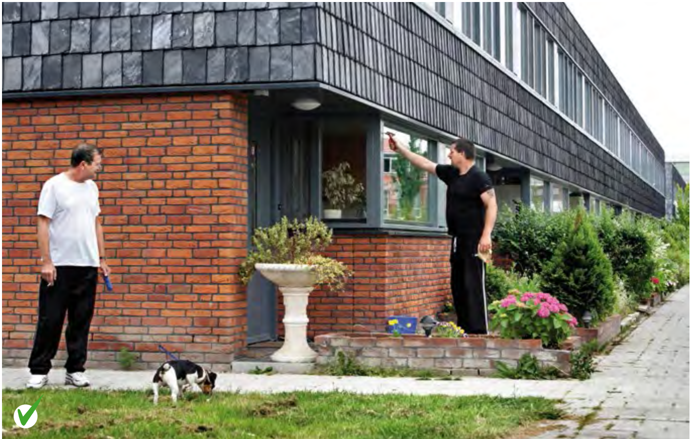
Deze gevel met glas geeft een goed zicht. Goed buurtcontact is belangrijk bij sociaal toezicht in de wijk.
