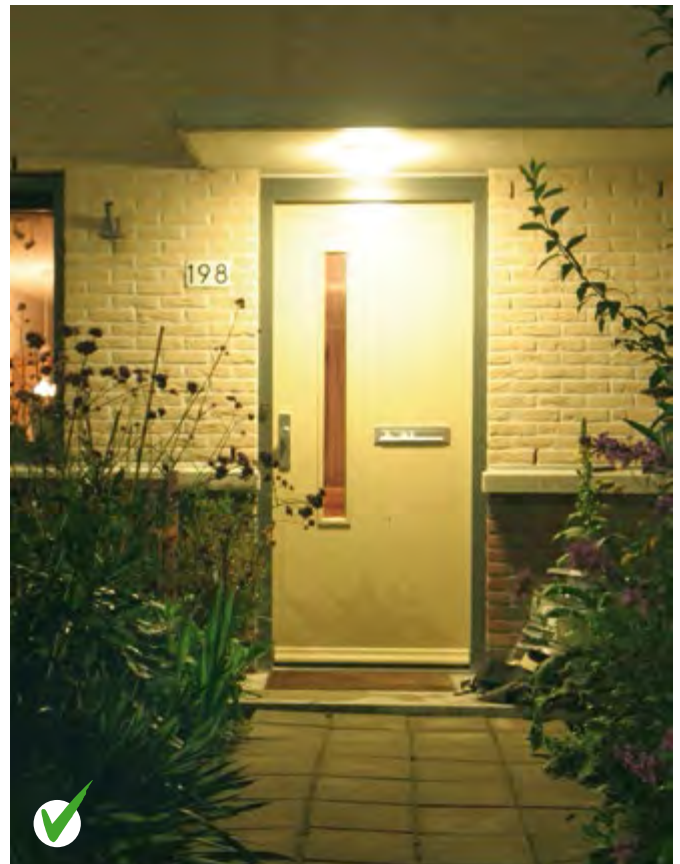
Goed: verlichting maakt de voordeur goed zichtbaar. Bij voorkeur is de lamp naast de deur geplaatst.
