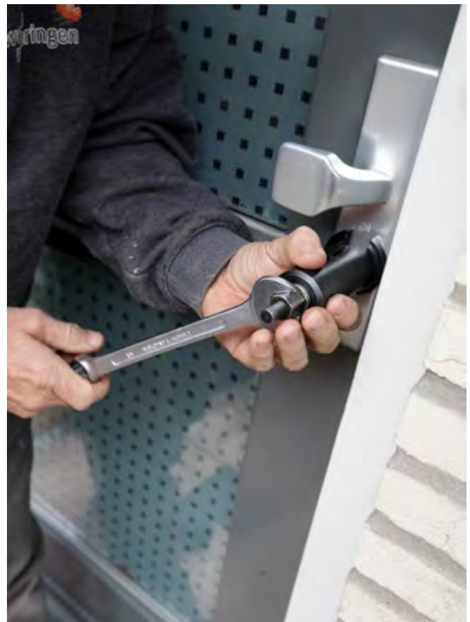
Modus operandi cilindertrekken. Cilindertrekbeveiliging is hiervoor de oplossing.
