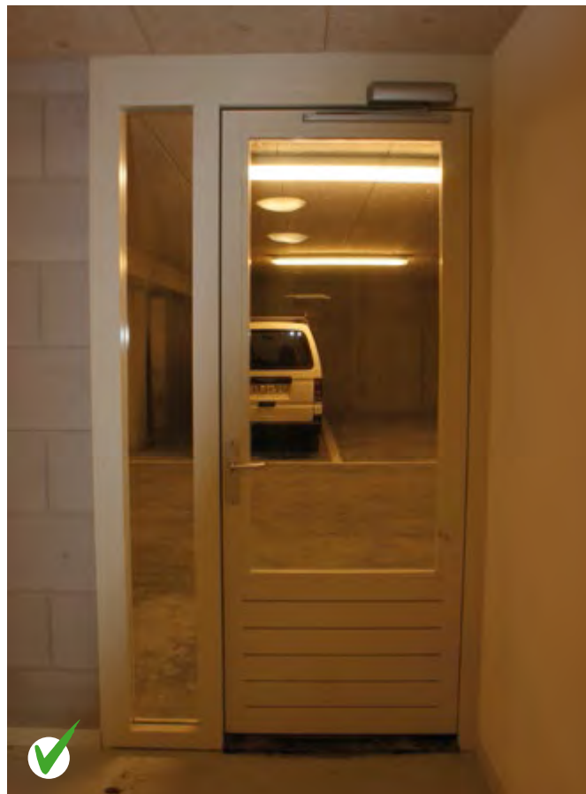
Voor het binnengaan van een garage, moet al voldoende zicht zijn op de situatie in de garage.
