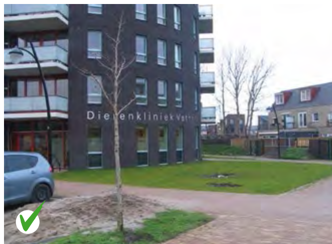
Goed: een voorziening in een woongebouw met eigen entree.
