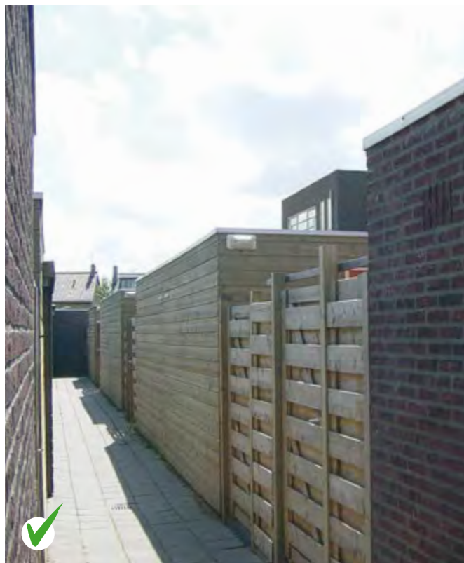
Goed: hier is een combinatie van het verlichten van de bergingsdeur en het achterpad goed te zien.
